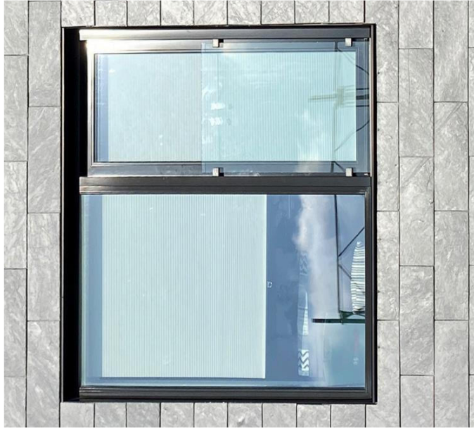
Eksempel, facade og vindue
